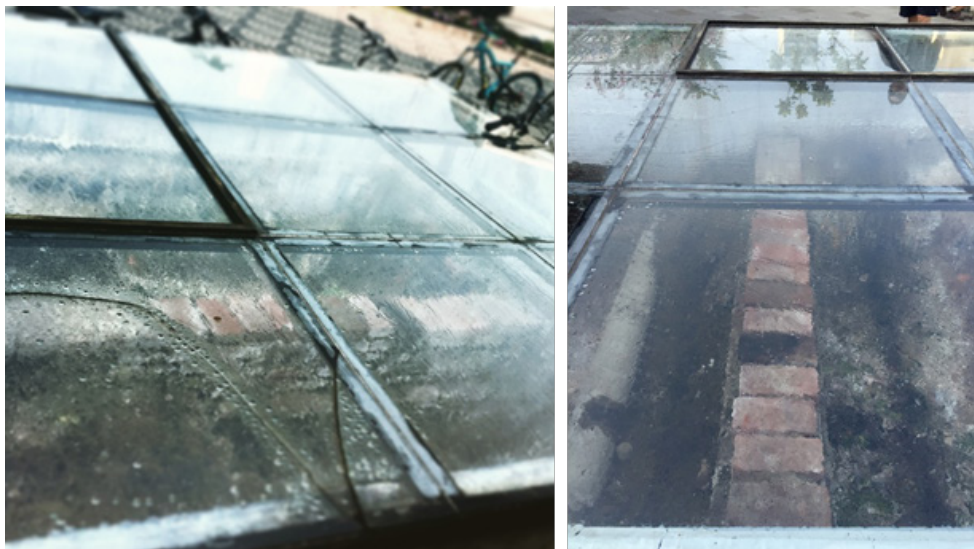
Gambar 5. Sisa pondasi satu bastion / kubu tembok Batavia, pondasi bastion sisi selatan, di belakang Museum Bank Indonesia
