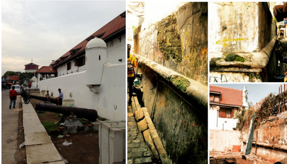
Gambar 3. Tembok Kota sisi Gudang Barat, sebagian kondisi tembok kota sudah diperbaiki, tetapi sisi utara Bastion Zeeburg masih terlihat asli
