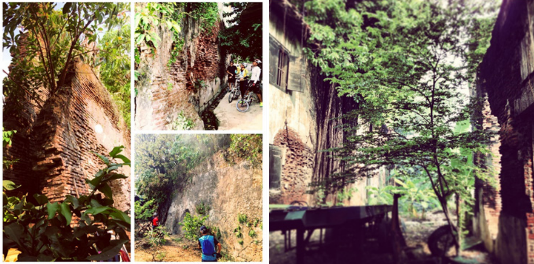
Gambar 4. Tembok Kota Gudang Timur dan sisa Gudang Gandum, tembok kota tersisa masih asli dari 4 Gudang Gandum, hanya tersisa 1 bangunan.
