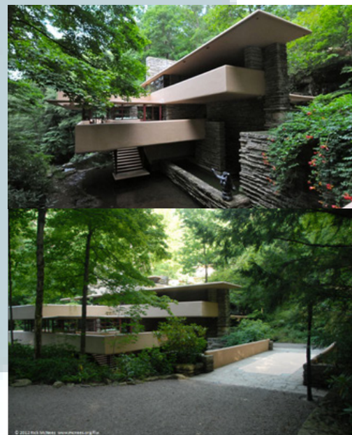
Gambar 1. Penerapan Modernisme pada bangunan Falling Water karya Frank Lloyd Wright. Sumber : https://en.wiki- pedia.org/wiki/Fallingwater (akses tang- gal : 1 September 2017)
